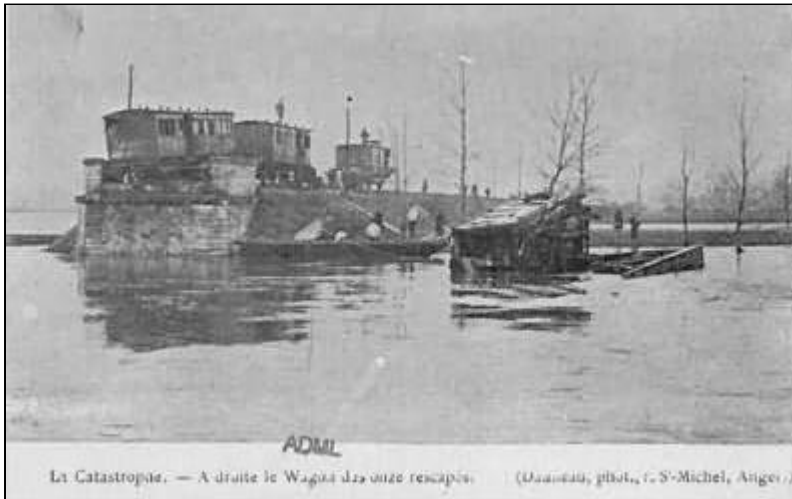
Catastrophe ferroviaire, 23 novembre 1911. À droite, le wagon des onze rescapés.
