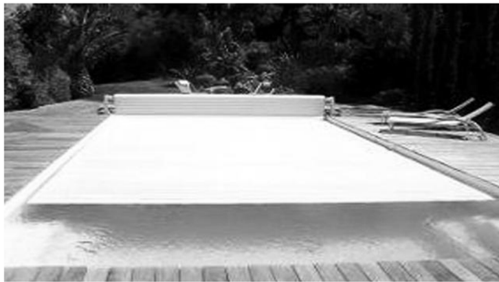
Piscine munie d'un volet roulant
