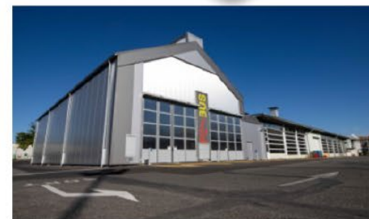
Atelier de maintenance dédié aux bus H2 (ATEX/ICPE)
