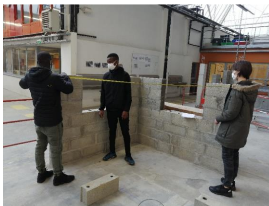
Photo 13 : Mesure de l'hypoténuse non matérialisée par un mur
