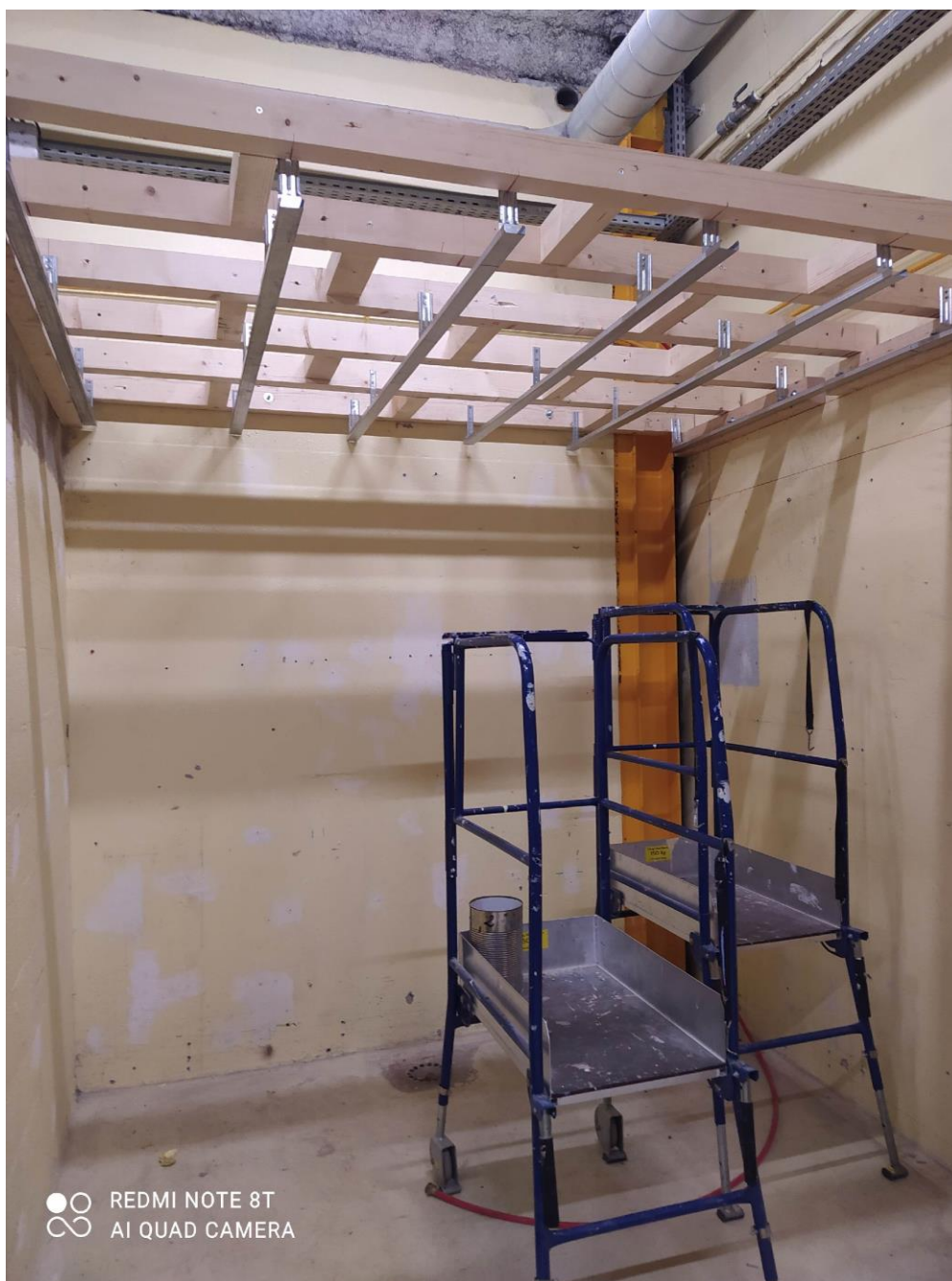
Charpente réalisée et posée par les 2 ème années CAP menuisier
