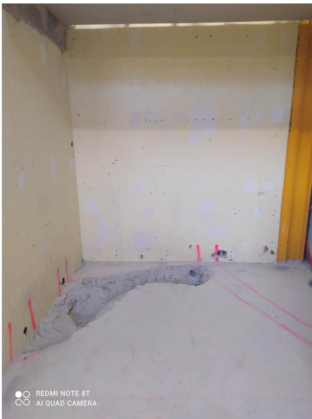
Tranchées réalisées par les CAP Maçons 2 ème année pour le passage des tuyaux d'évacuation PVC.
