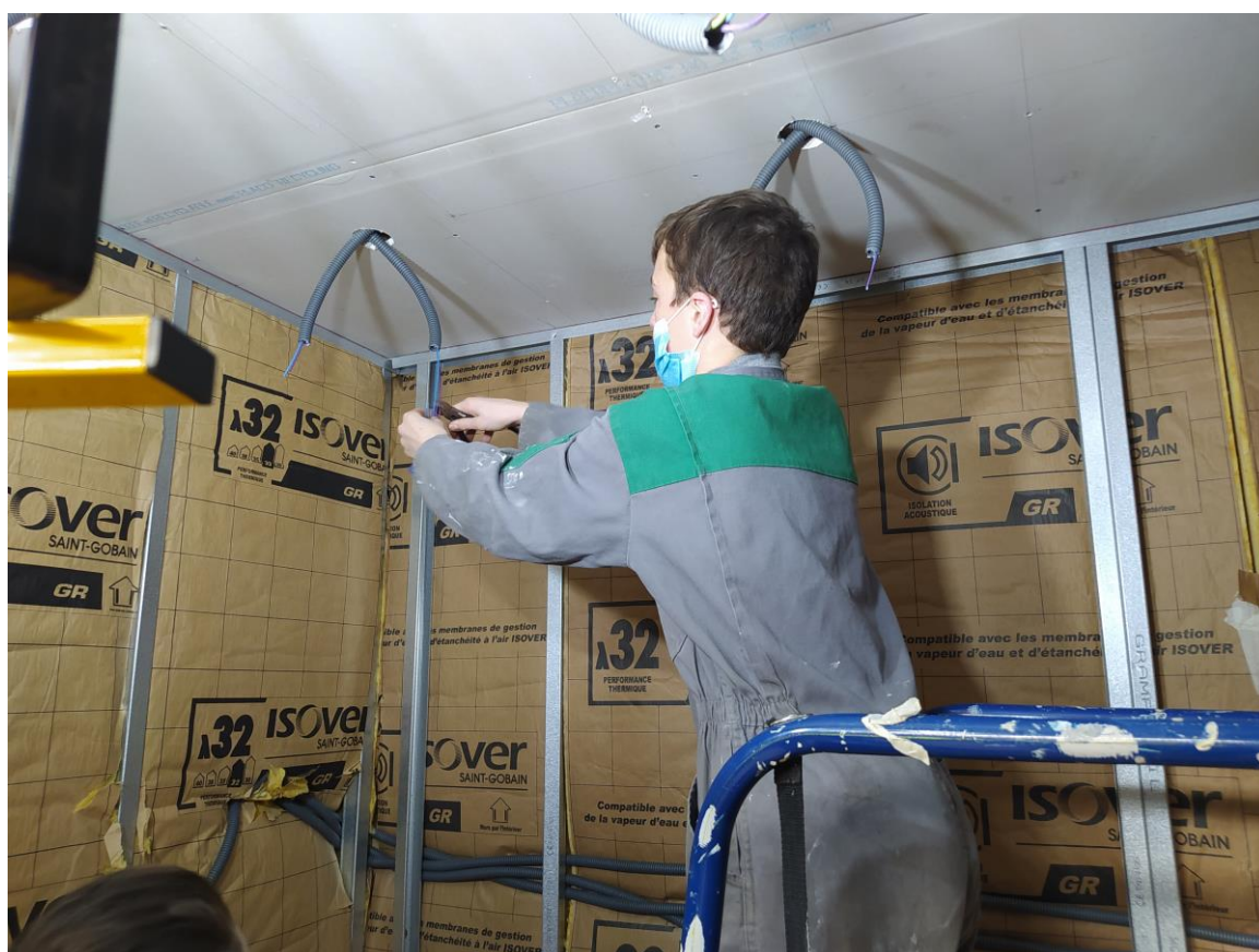
Passage des gaines et des câbles, pose et câblage de l'éclairage réalisé par les élèves de 3 ème .
