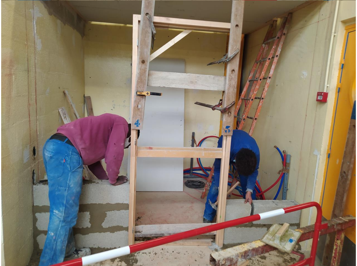
Les CAP Maçon posent les parpaings afin de réaliser le mur de la porte d'entrée, l'huissierie a été réalisée et posée par les CAP Menuiserie.
