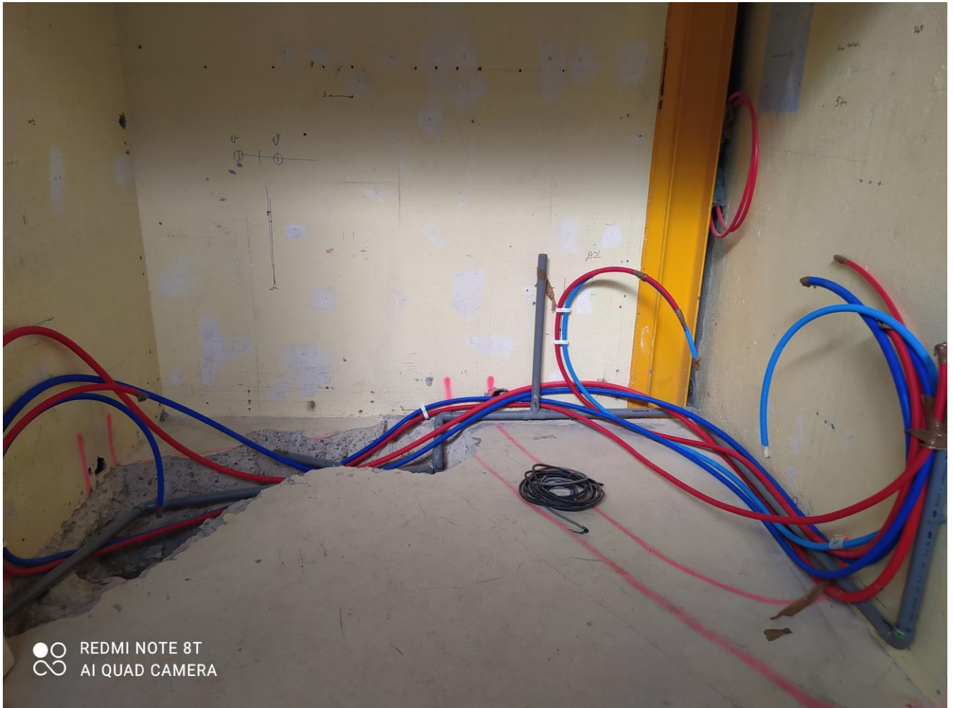
Réseau d'alimentation eau froide et eau chaude en PER, réalisé par les 1 CAP MIS
