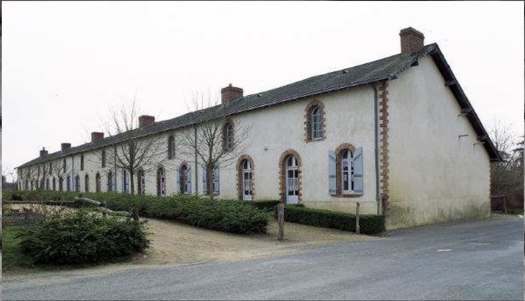
Logements ouvriers, Noyant-la-Gravoyère
