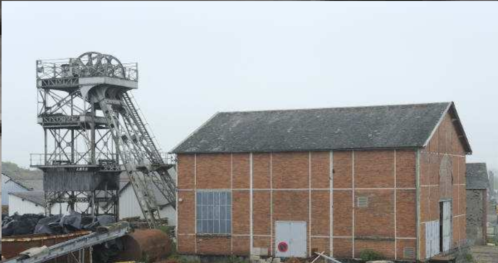
Chevalement et bâtiment de la machine d'extraction, Misengrain, Noyant-la-Gravoyère
