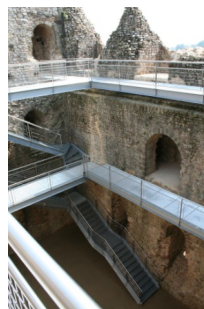
Intérieur du donjon après restauration
