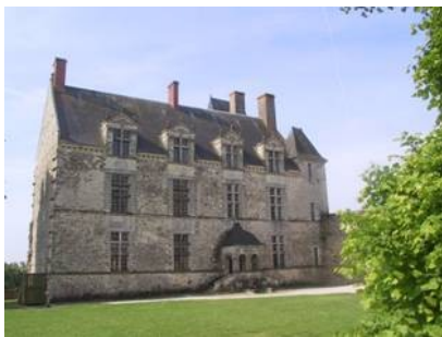
Logis avant restauration Sainte Suzanne
