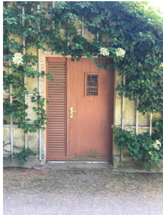
Porte et côté gauche de la porte à peindre
