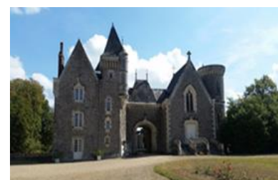
Château de Bourmont à Freigné
