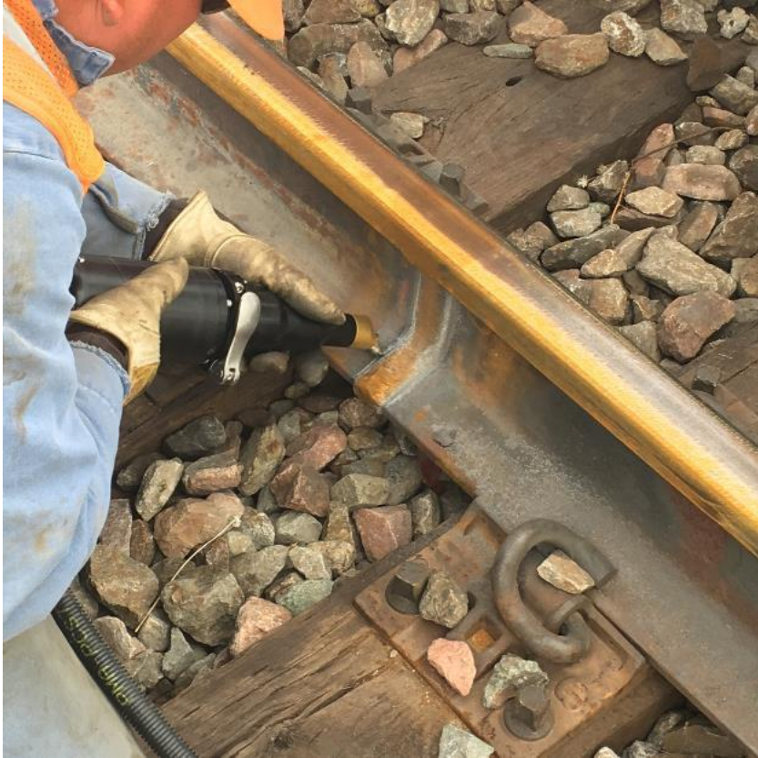
▶ Martelage ultrasons de soudure (haute fréquence)
