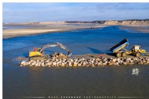
Construction d'un brise-lame
