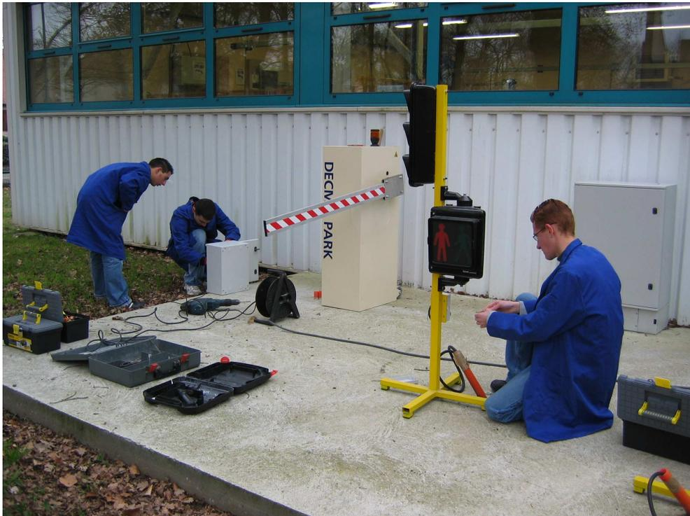
Remarque : les feux et la barrière sont raccordés au dernier moment grâce à des connecteurs rangés avant raccordement dans des coffrets étanches
