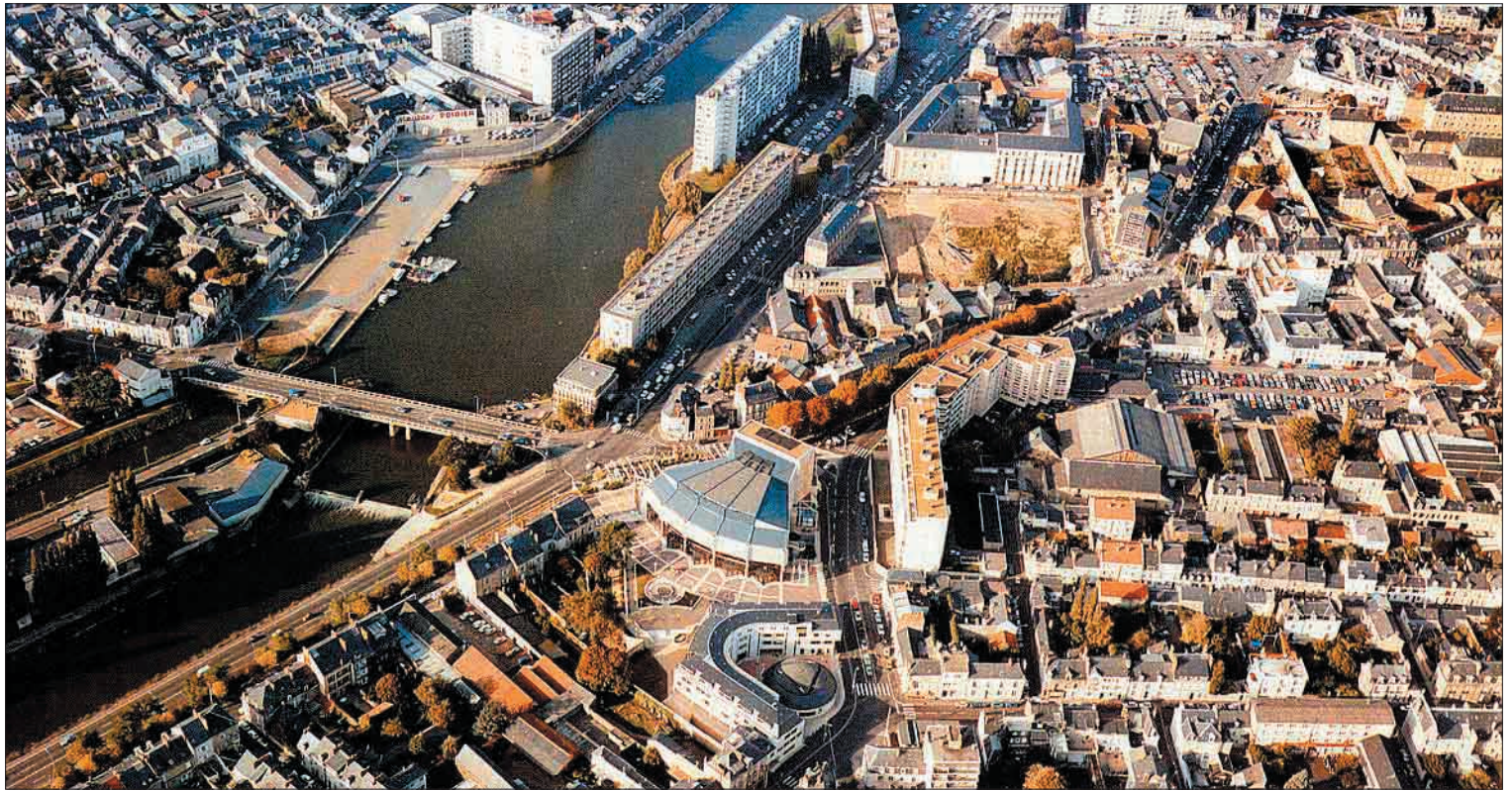
Cité Cénomane, Palais des Congrès (photo Services Techniques CUM)
