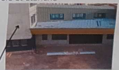
Les prémurs visibles lors de la construction du collège
